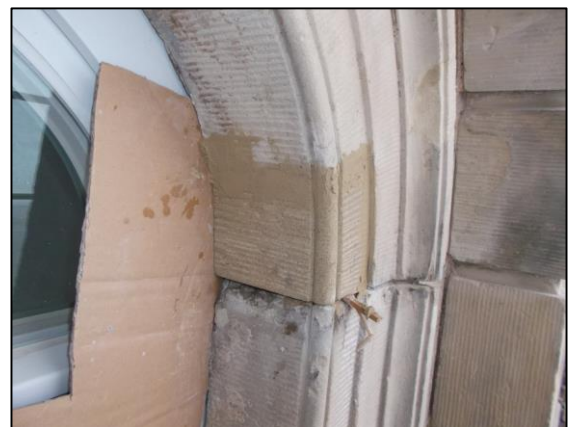
Ergänzen eines Zahnschnittfrieses mit Vierungen (oben), plastische Steinerergänzungen (unten).
