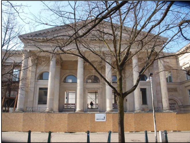
Aufnahme des klassizistischen Portikus an der Ostseite.
