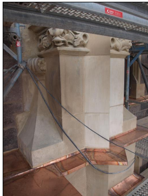
Teilrekonstruierte Wandvorlage im unteren Bereich des Turmschaftes (Südfassade).
