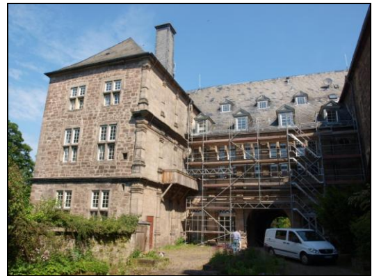
Ansicht der Fassaden aus nördlicher und südlicher Richtung.
