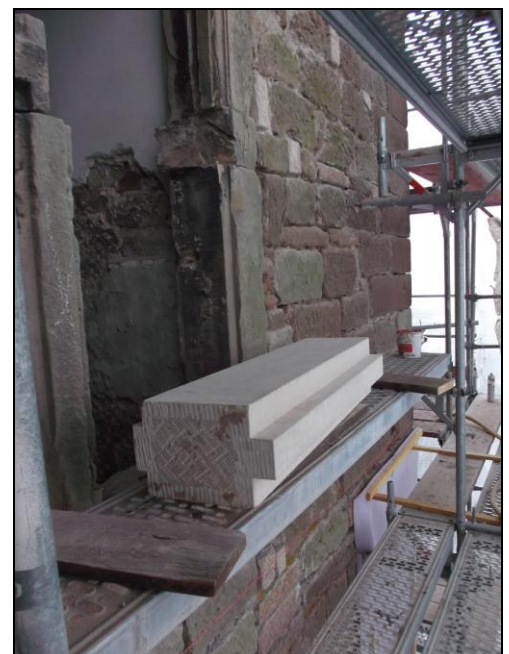
Teilerneuerung eines schadhaften Kreuzstockfensters.
