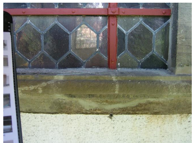
Steinergänzung im Bereich einer Fenstersohlbank
