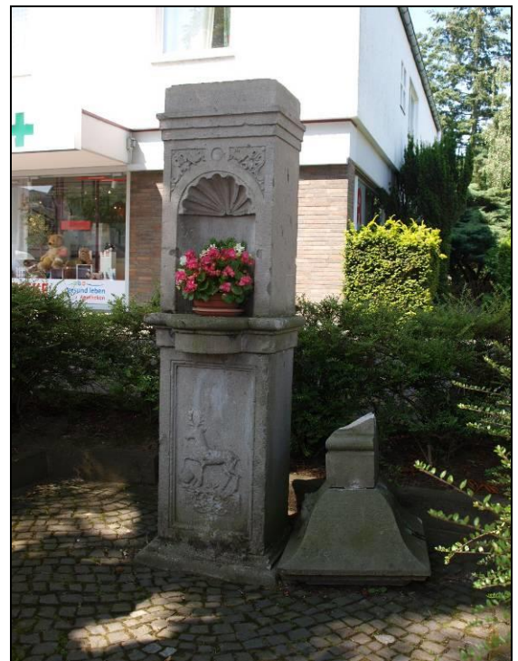
Ansicht des stelenförmigen Unterbaus mit herabgestürzter Kreuzbasis im Vorzustand. Der Kreuzaufsatz mit Corpus war ortsnah zwischengelagert.
