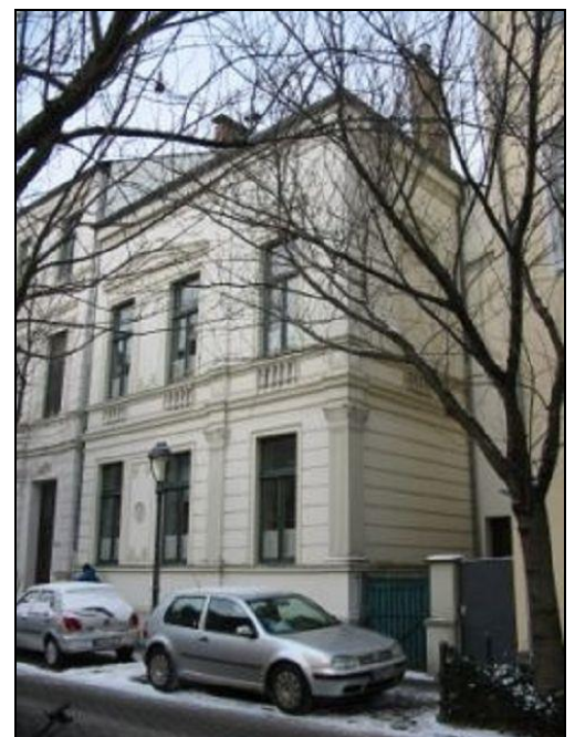
Ansicht der Fassade vor Restaurierungsbeginn.
