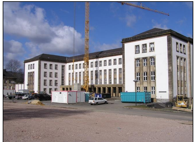
Teilansicht des Gebäudekomplexes aus südöstlicher Richtung im Vorzustand.
