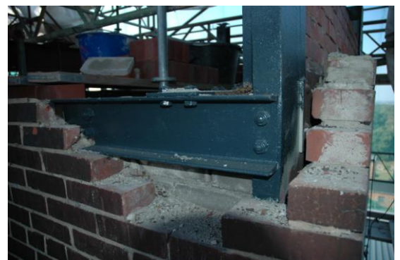
Teilsichten des partiell erneuerten Klinkermauerwerkes in und vor der sanierten Stahlkonstruktion.
