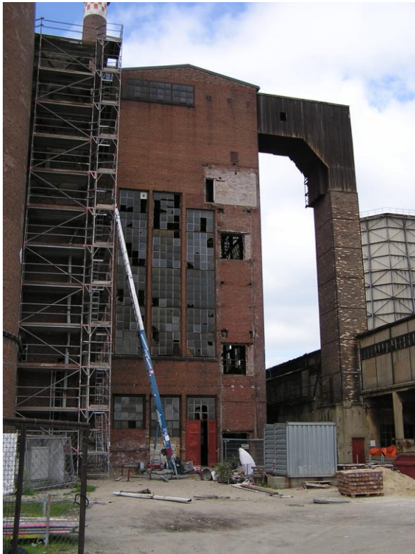
Teilsicht des Kesselhauses mit dem Hochbunker.
