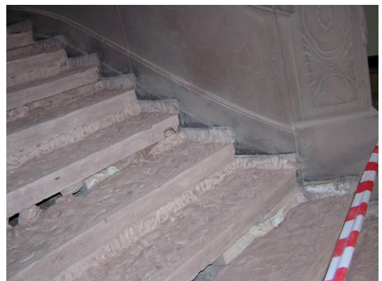
Treppenhaus mit ausgearbeiteten Treppenstufen
